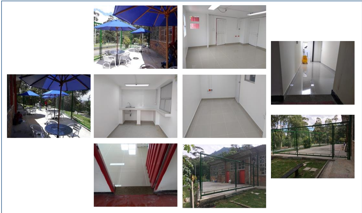
Figura . Instalaciones Parque Nacional: adecuaciones cafetería, consultorio, adquisición de parasoles y sillas. Demolición de muro posterior, cerramiento en malla, placa en concreto para parasoles, construcción de consultorio, mesones para cafetería y zona de almuerzos, instalaciones hidro-sanitarias, y eléctricas
