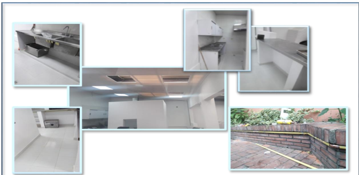
Figura 30. Instalaciones El Nogal: adecuaciones en área de cocina, trampas de grasas y red de gas natural.
