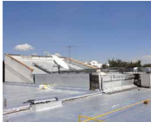
Imagen 9. Impermeabilización de las terrazas en los edificios B y C
