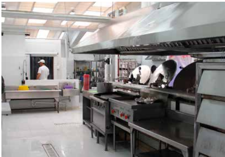
Imagen 5b. Cambio de pisos y readecuación de equipos
