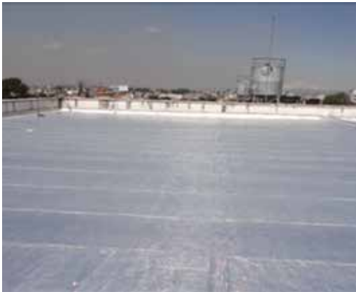
Imagen 9. Impermeabilización de las terrazas en los edificios B y C
