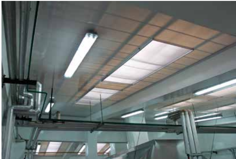
Imagen 5a. Nueva cubierta e iluminación en cocina del restaurante
